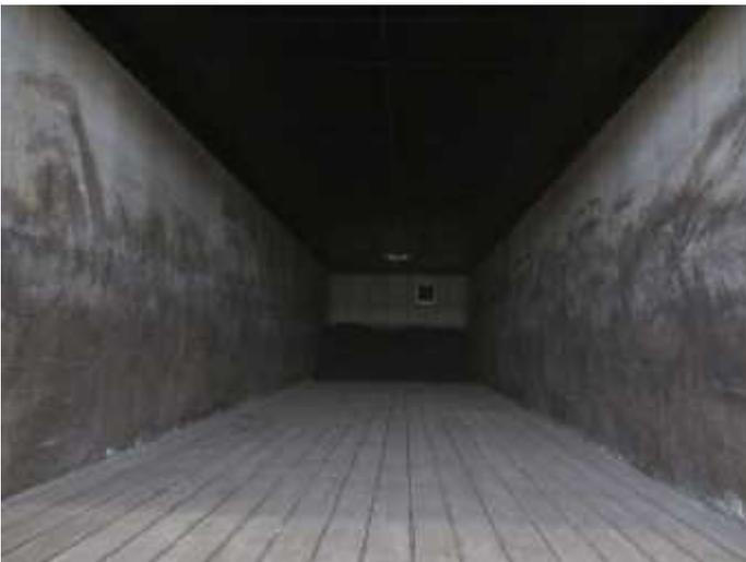
La prima fase, denominata di bio-ossidazione intensiva, avviene mediante la deposizione del materiale in cumuli posto all'interno di box chiusi (**biotunnel** o **biocelle**), dotati di un pavimento ventilato e di un sistema di aspirazione dell'aria esausta.
