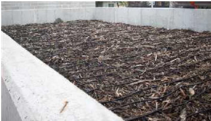
popolazione batterica, la cui funzione è quella di degradare biologicamente le sostanze organiche volatili a composti elementari, anidride carbonica, azoto e acqua. La tecnica in generale mostra un'alta efficienza di abbattimento di circa il 90%.
