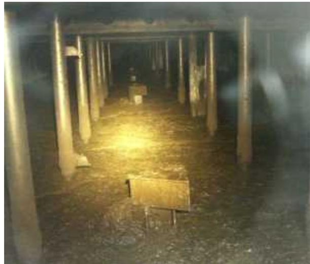
Il digestore è riempito per 3/4 con biomassa, in particolare il livello di carico viene mantenuto tra l'85 % (max) ed il 70 % (min) dell'altezza interna del fermentatore. Un PLC controlla permanentemente il livello del materiale all'interno del digestore; se questo scende sotto il livello minimo si arresta l'estrazione, mentre se sale sopra il livello massimo si arresta l'alimentazione.
