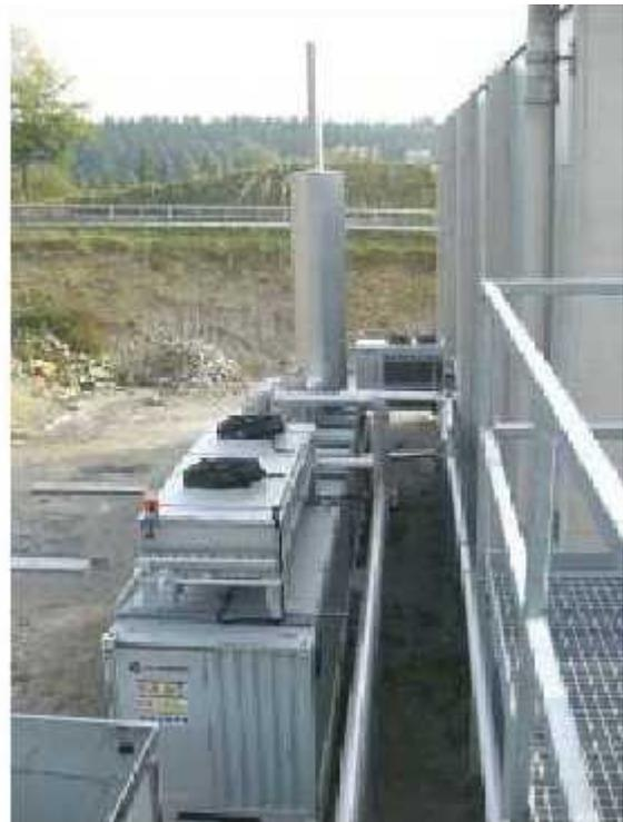
L'impianto di cogenerazione è costituito da un modulo di cogenerazione di energia elettrica e termica, predisposto per funzionamento in parallelo alla rete elettrica, con recupero termico, alloggiato in apposito container insonorizzato (rumorosità esterna 70 dB).
